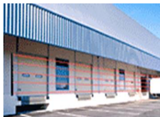
Na zdjęciach widać sposób zastosowania w praktyce barier firmy NEWTON (dł. fali – 950 nm) dla ochrony obiektu rozległego (budynek, parking, garaże).
